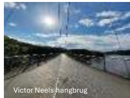
Victor Neels hangbrug
